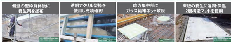
コンクリート品質の確保(ひび割れのない密実なコンクリートの実現)
